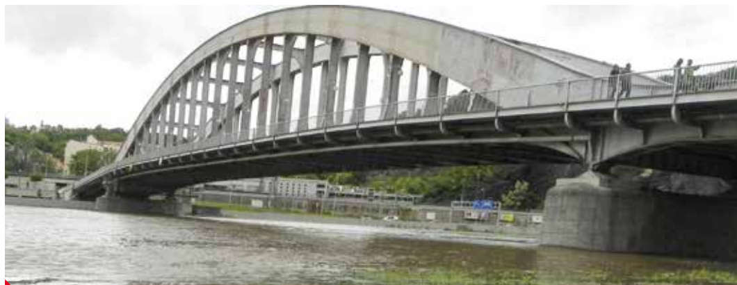
Cena rekonstrukce ústeckého mostu vyšplhá k půl miliardy korun. FOTO: ZK
