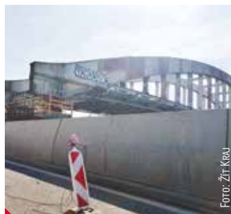
Aktuálně rekonstrukce chátarjícího mostu vychází na 659 milionů korun, což je zhruba
